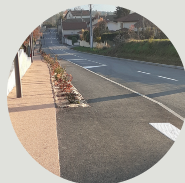
La route de Vouise rénovée
