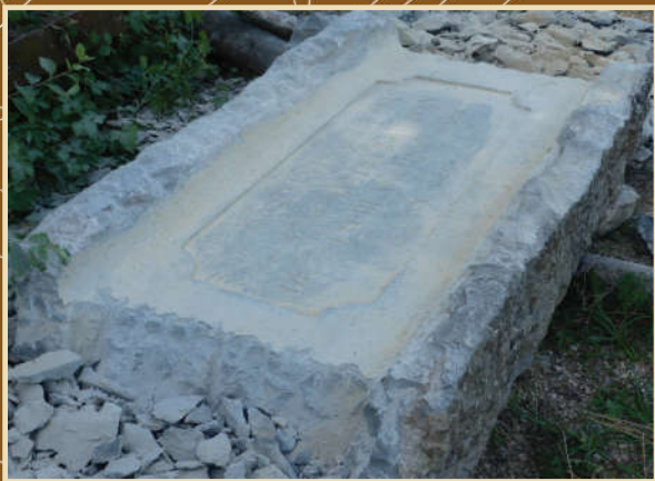
Début de restauration - septembre 2016
