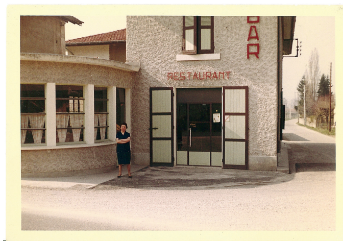
Nouvelle salle construite en 1956
