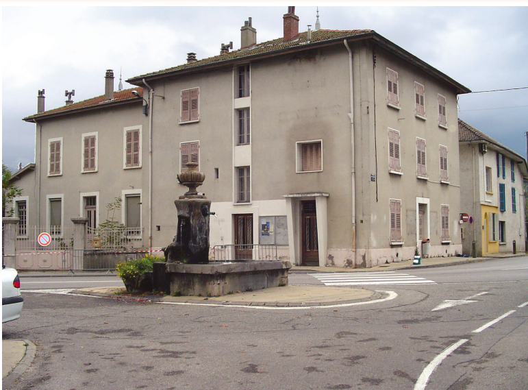
Ancienne mairie (avant sa démolition) et la fontaine du Thomas.
