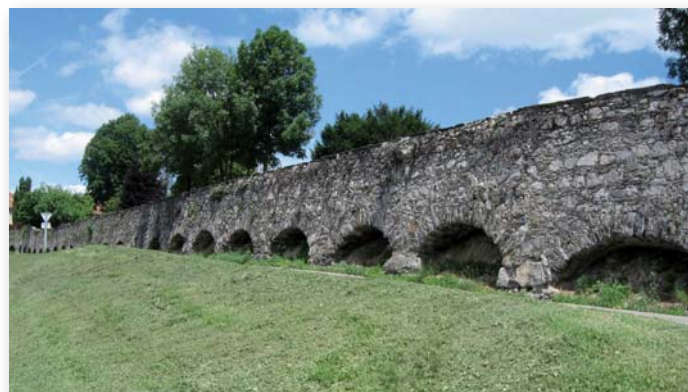
Mur du chemin des Voutes
