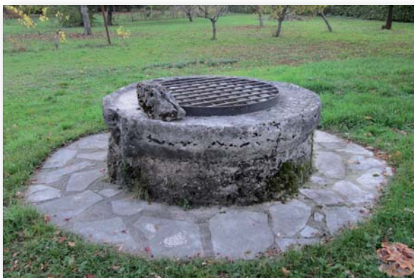
Puits du domaine de Voissant
