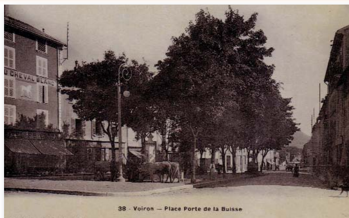
Place porte de la Buisse
