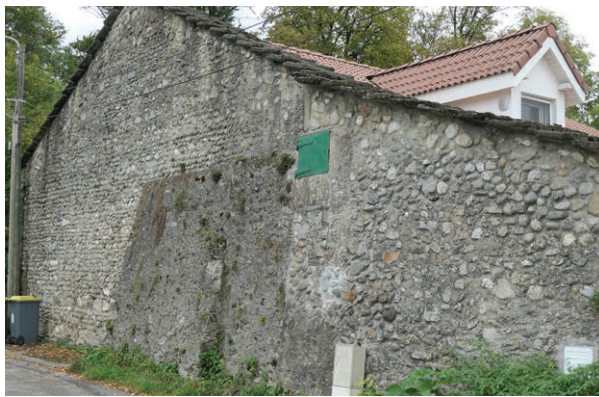
Le réservoir des eaux Battier, chemin de Coublevie
