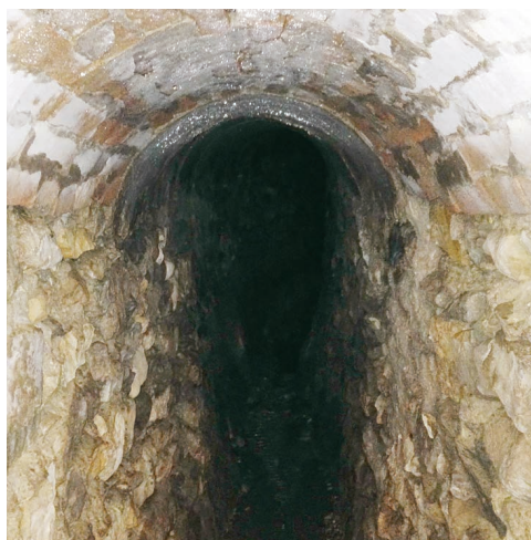
Le tunnel de captage (eaux Blanchet) sous le chemin piétons
