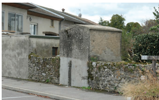
Réservoir des eaux SNCF à Voissant
