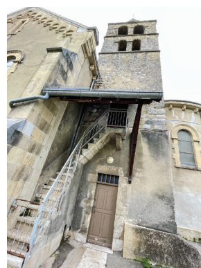
Accès extérieur clocher
